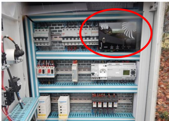
Unité de télégestion intégrée dans l'armoire de commande
