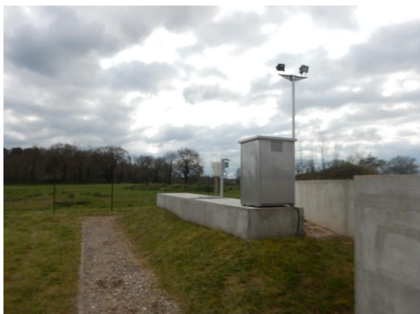
Canal de comptage et préleveur réfrigéré
