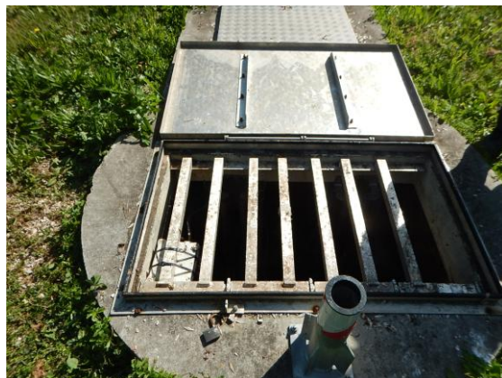
Barreaudage anti chute sur cuve de pompage
