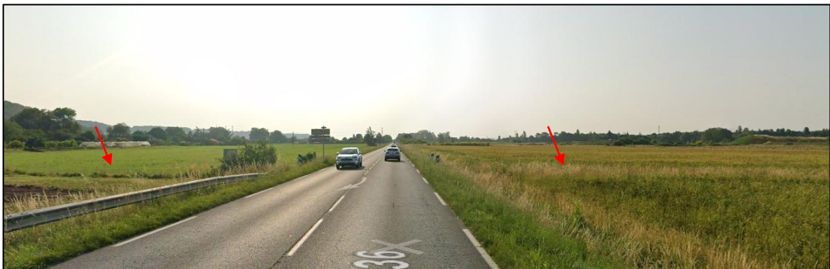
3 – La limite entre les 2 communes marquée par le fossé - Streetview juin 2025
