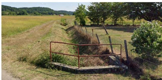
Vue du fossé en sortie du site Source : googlestreet 2021
