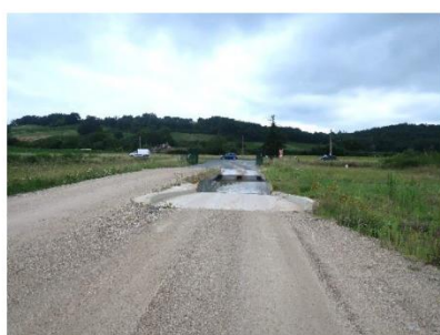
Entrée de la carrière de Saint-Antoine-de-Breuilh Source : ARTIFEX 2021
