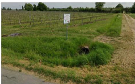
Vue du fossé 320 m en amont hydraulique du site du projet Source : googlestreet 2021
